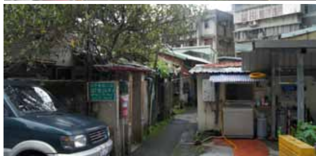
更新前多為1~2層磚造建築，鄰棟間隔不足，不利消防救災
