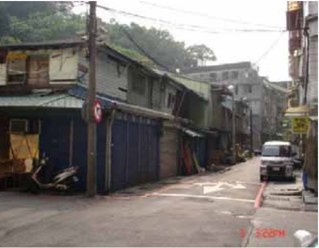
基隆市首件都市更新事業申請案-更新前建物現況
