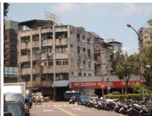
更新前屋況老舊待修
