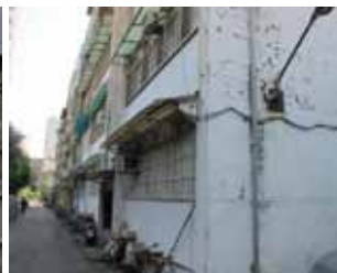
更新前多為4層磚造建築
